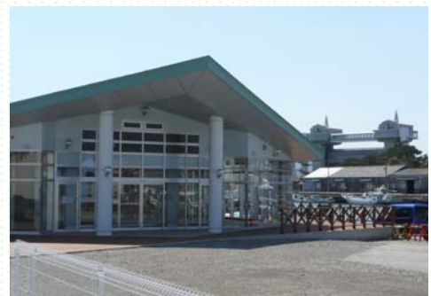
4月26日のオープンに向け工事が進む「沼津みなと新鮮館」
