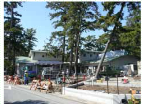
4 月開所に向け建設工事が進む生活介護事業所「ミルキーウェイ」
