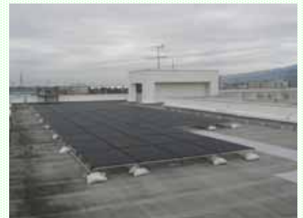
開北小学校屋上の太陽光発電パネル
