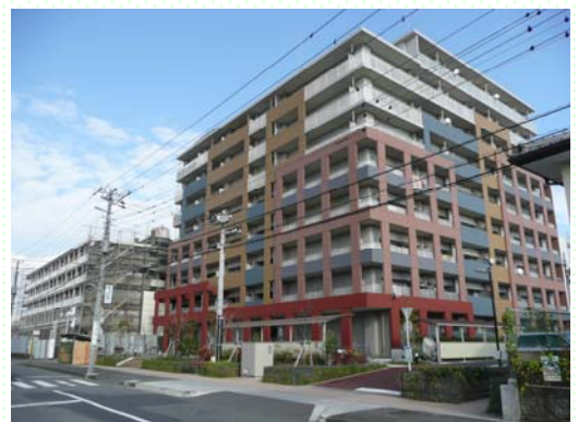
第三期工事が進む沼津市営自由ヶ丘団地
