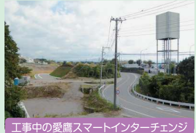
工事中の愛鷹スマートインターチェンジ
