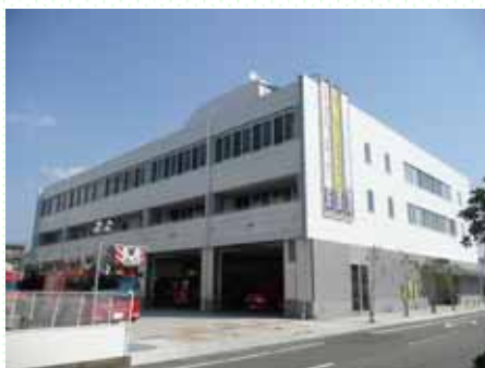
リコー通り西側に新築され10月から業務を開始した沼津市消防本部・北消防署
