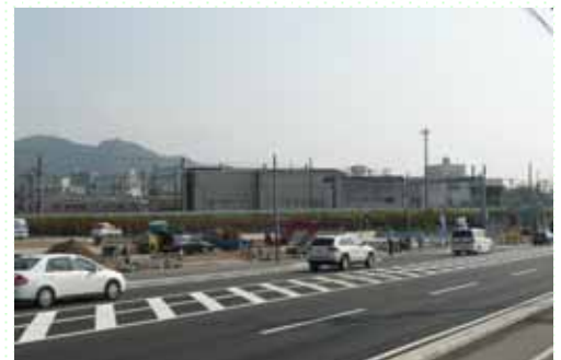
静岡東部拠点第一地区土地区画整理事業にて整備中の旧三枚橋字日ノ出町地先
